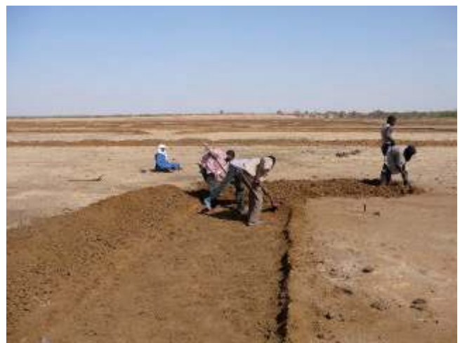
Construction de « banquettes » sur le site de Tigougout
